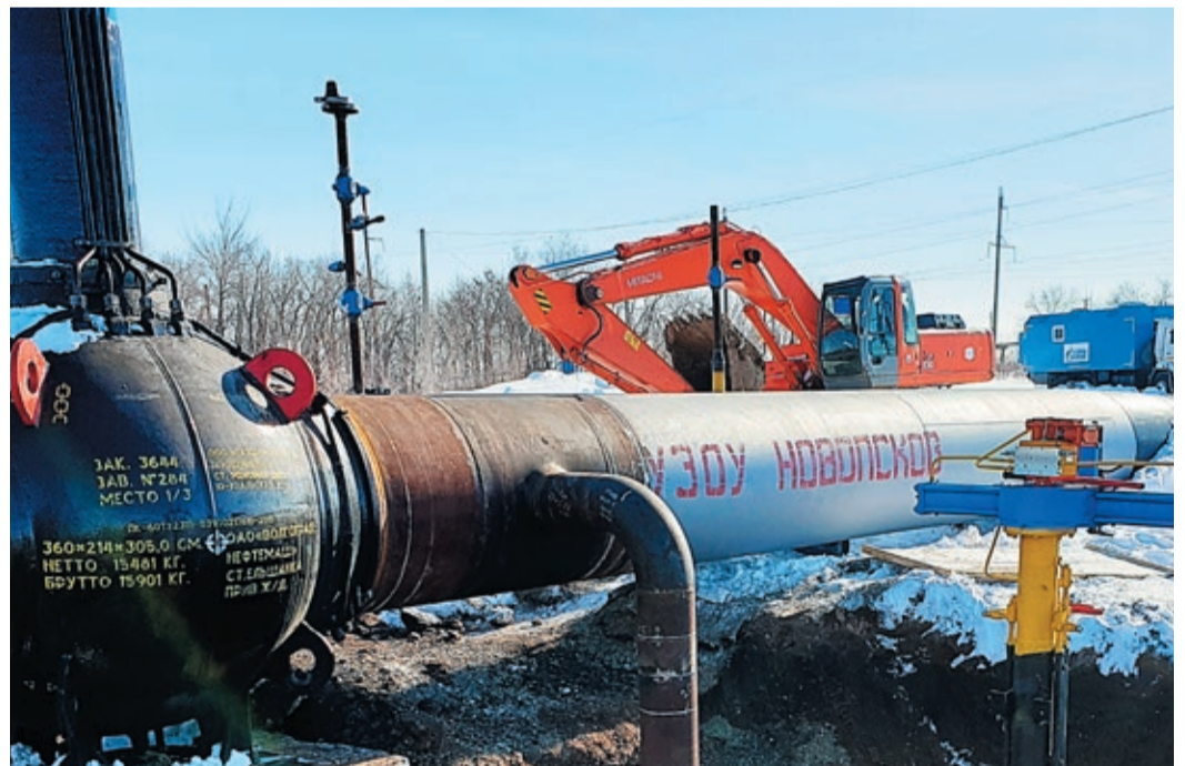
Новый кран «работает» затвором на камере запуска внутритрубных устройств
