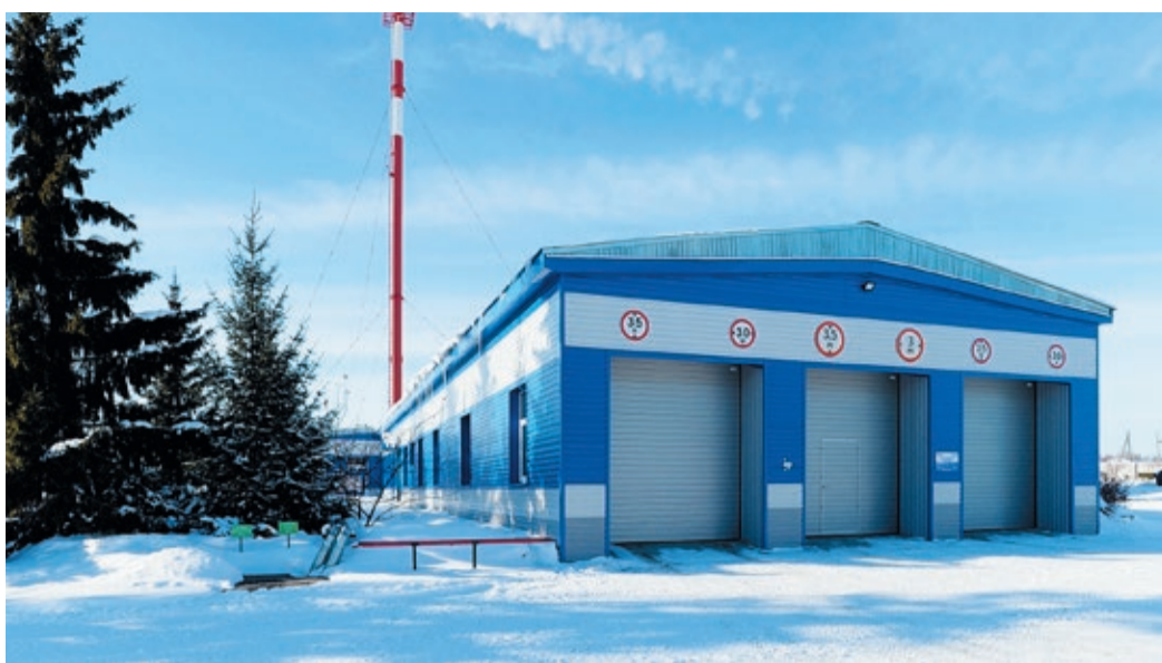
Сайдингом обшили и утеплили порядка 700 квадратных метров стен
