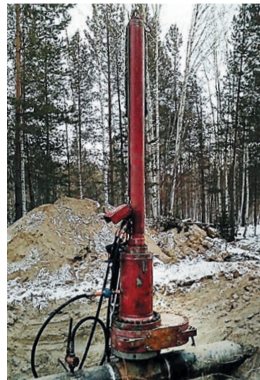
Заглушка-«стопл» перекрывает трубу не хуже линейного крана
