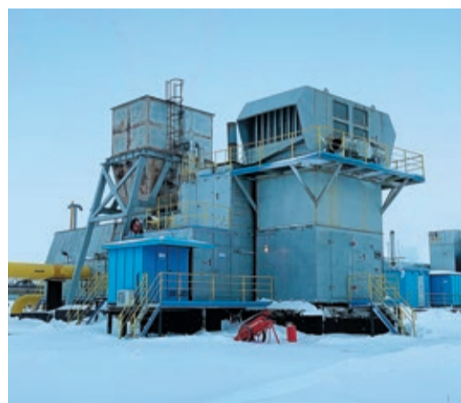
...подхватывает 16-мегаваттный агрегат Медногорской ГКС
