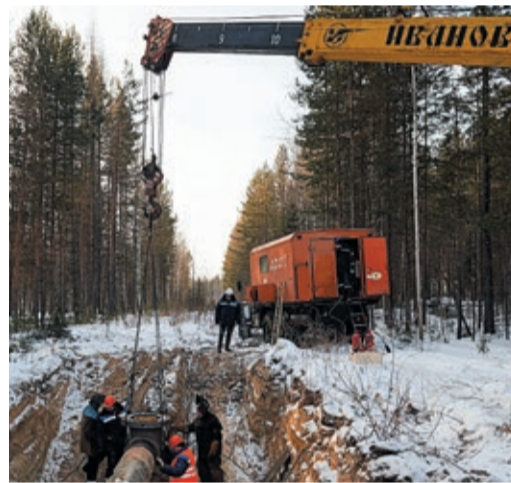
Врезка под давлением позволяет экономить голубое топливо
