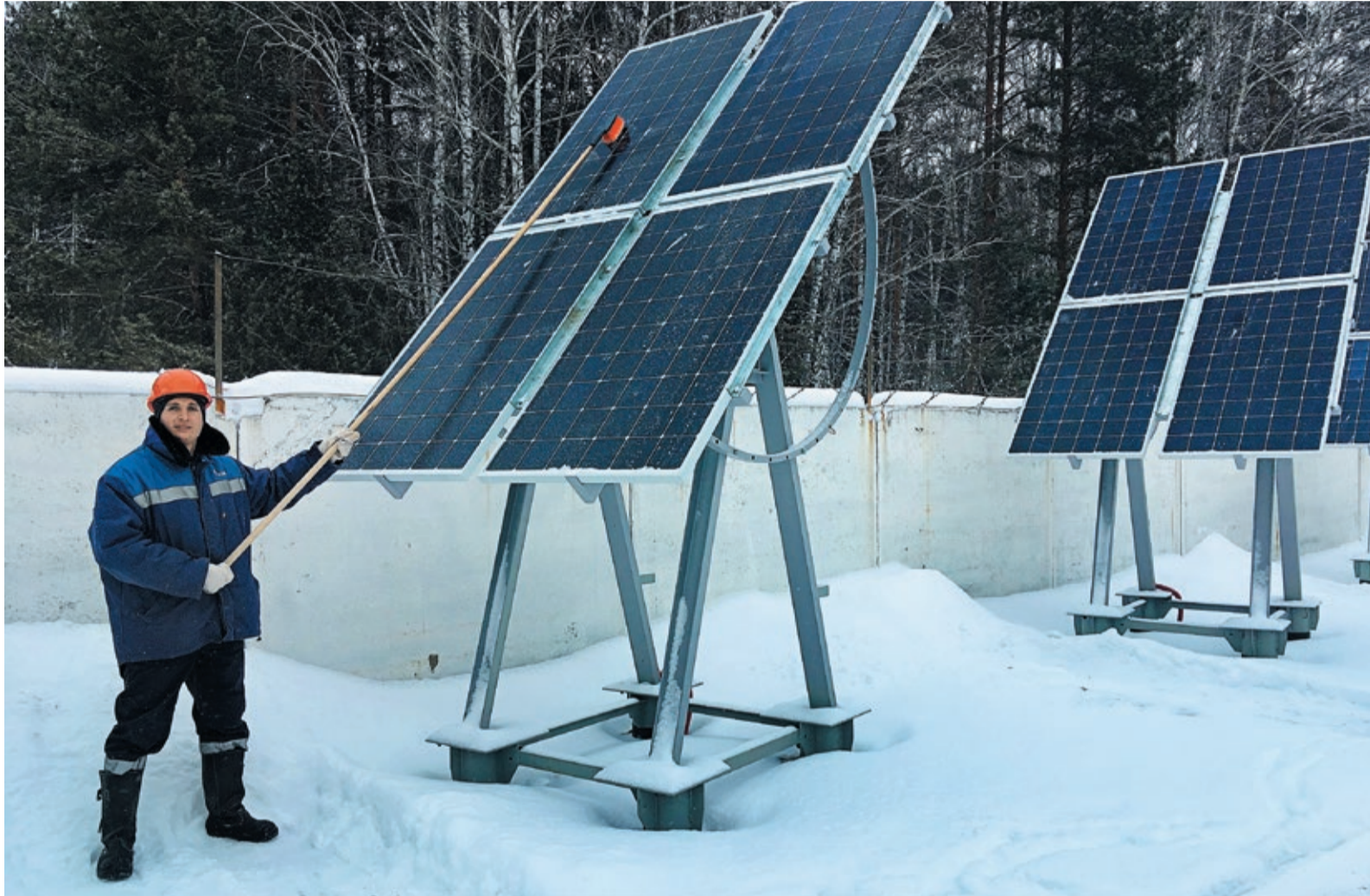
Есть у оператора ГРС города Миасса Василия Чельмекчи такая работа – снег с солнечных батарей убирать
