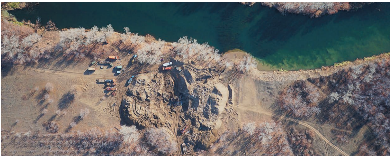
Котлован, выкопанный для ремонта стыка, с высоты птичьего полета
