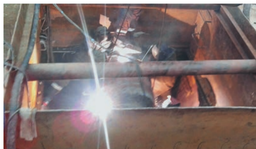
В кессоне одновременно могли работать четыре сварщика
