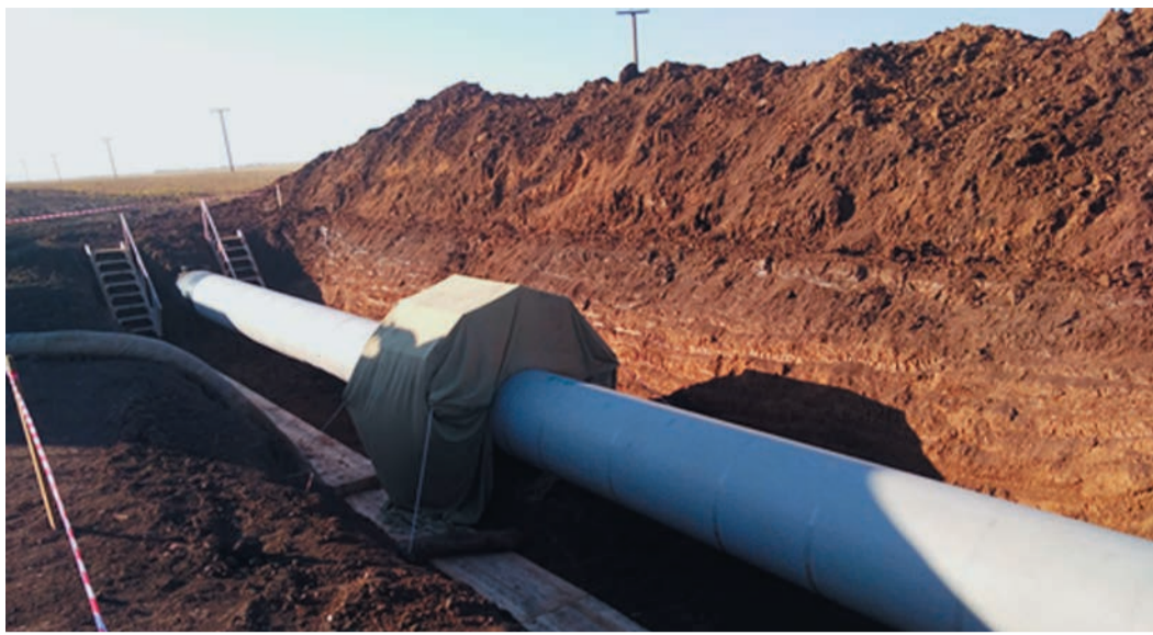
Новая эпоксидная изоляция хорошо подходит для труб, выпускаемых по технологиям «белой металлургии»
