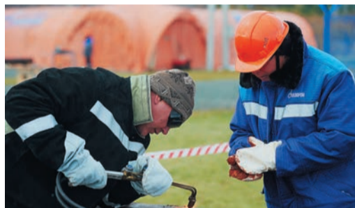
Вырезка технологических окон и обработка кромок трубы — не самые зрелищные, но одинаково важные моменты конкурса
