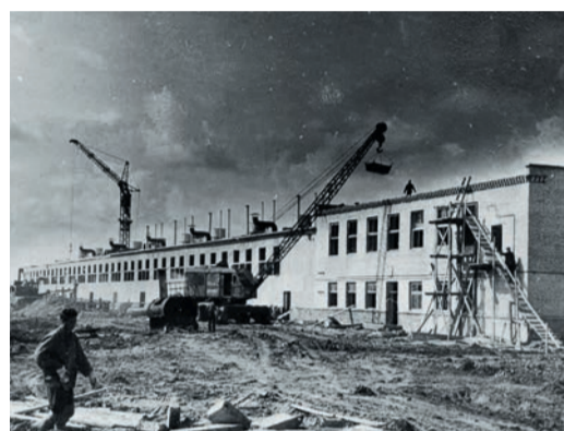
Строительство компрессорной станции стартовало 30 сентября 1963 года
