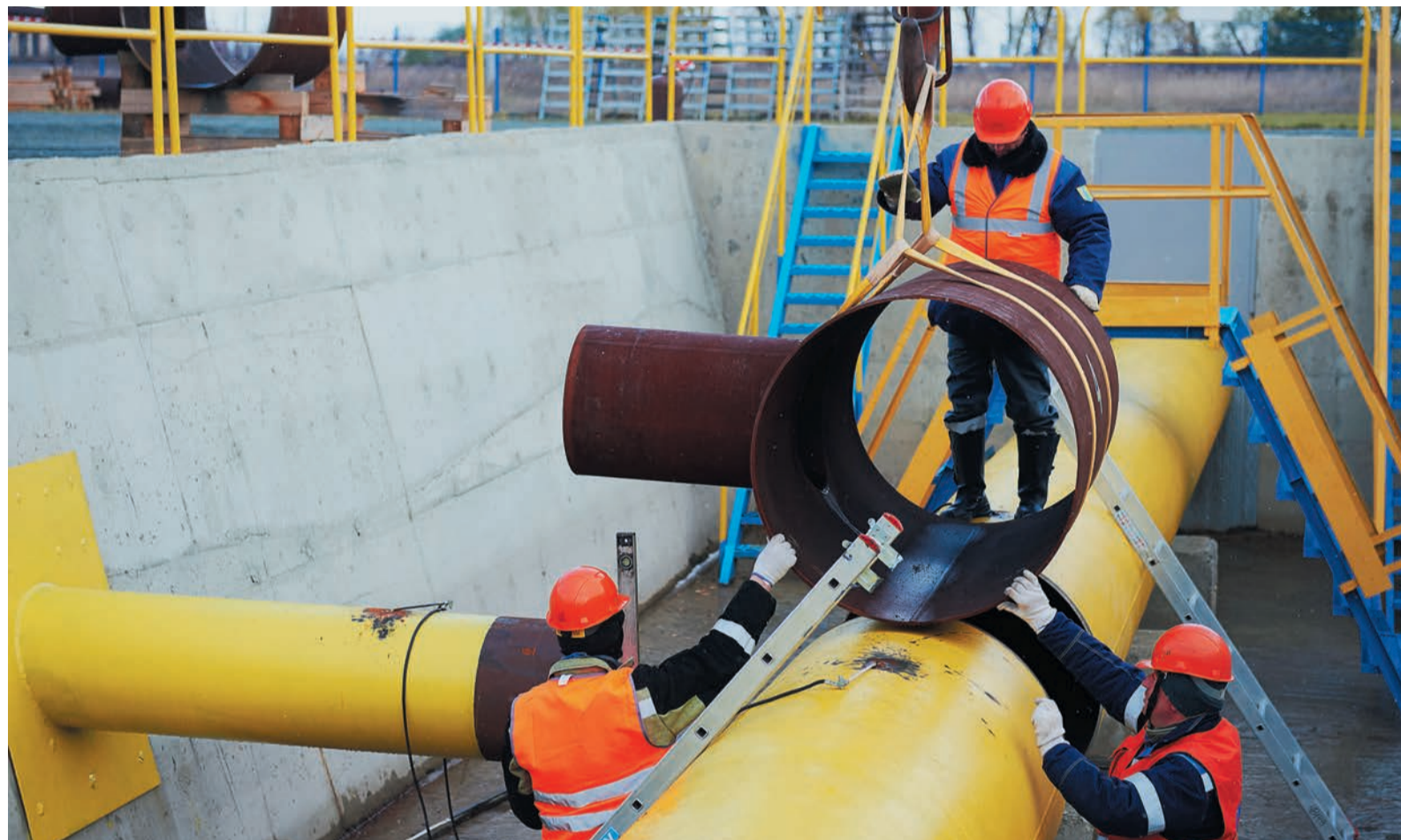
Подгонка и замена тройника — кульминационный момент в работе ремонтных бригад. Хотя на трассе, хоть на смотре профессионального мастерства
