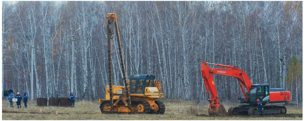
Открывают состязание машинист экскаватора и трубоукладчика...
