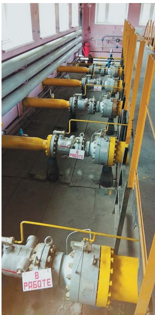
Новые регуляторы давления поставили на всех нитках редуцирования ГРС-2 города Челябинска
