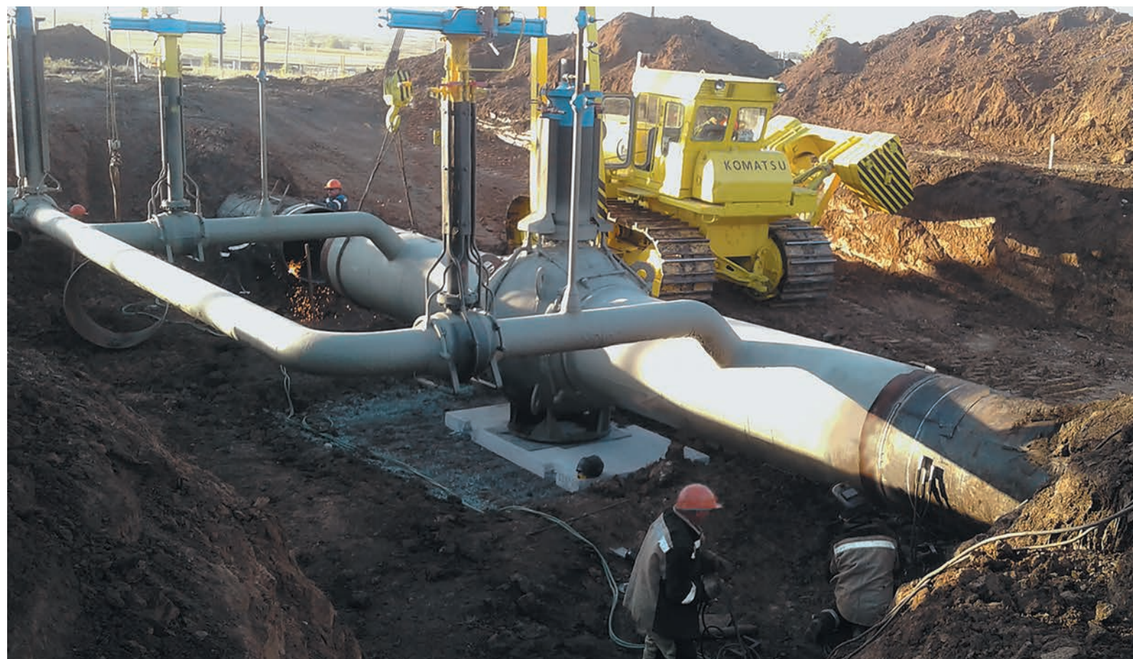
Самый тяжеловесный момент комплекса № 10 — монтаж кранового узла диаметром 1200 мм
