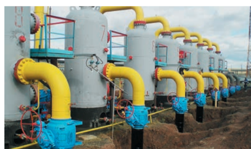
После ремонта на шлейфы нанесли защитное покрытие
