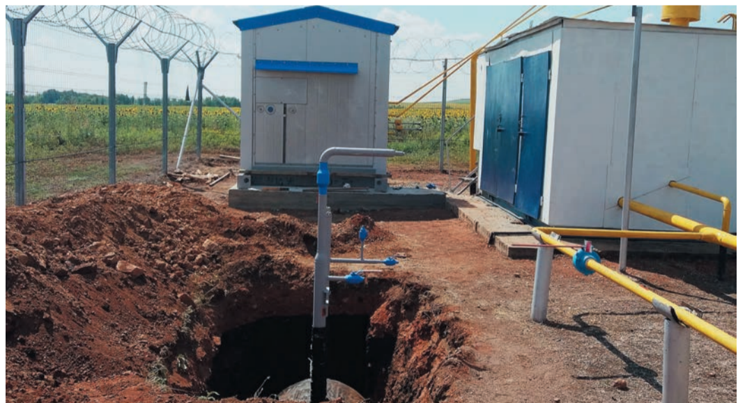
На ГРС «Бурунча» установили автоматический блок одоризации и новую емкость для «ароматизатора»
