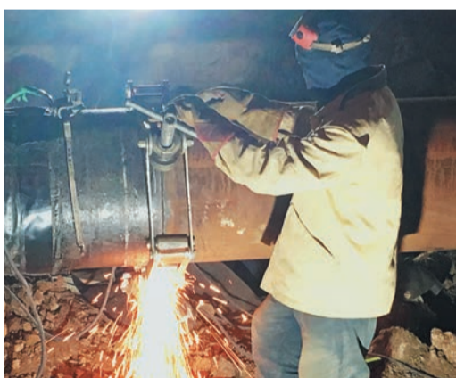
Ремонт продолжается даже ночью
