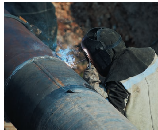
Пока газораспределительная станция была подключена к ПАГЗу, ремонтники успели устранить дефекты, вырезать тройник и поменять краны
