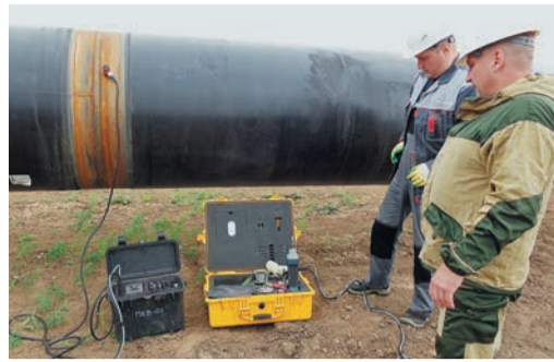
Все оборудование для дуговой пайки работает от аккумуляторов
