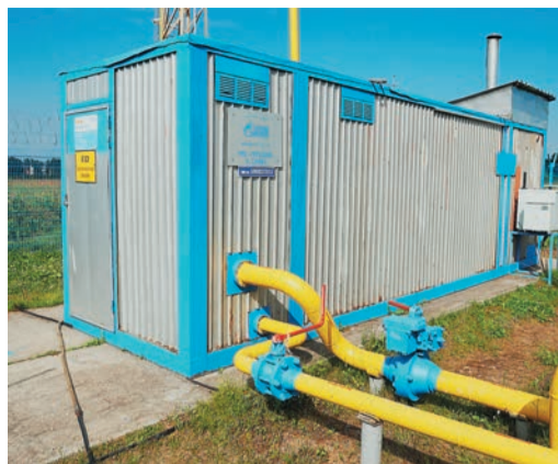
Пока газораспределительная станция была подключена к ПАГЗу, ремонтники успели устранить дефекты, вырезать тройник и поменять краны
