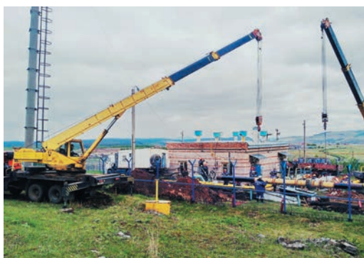
На ГРС демонтировали часть замерной нитки
