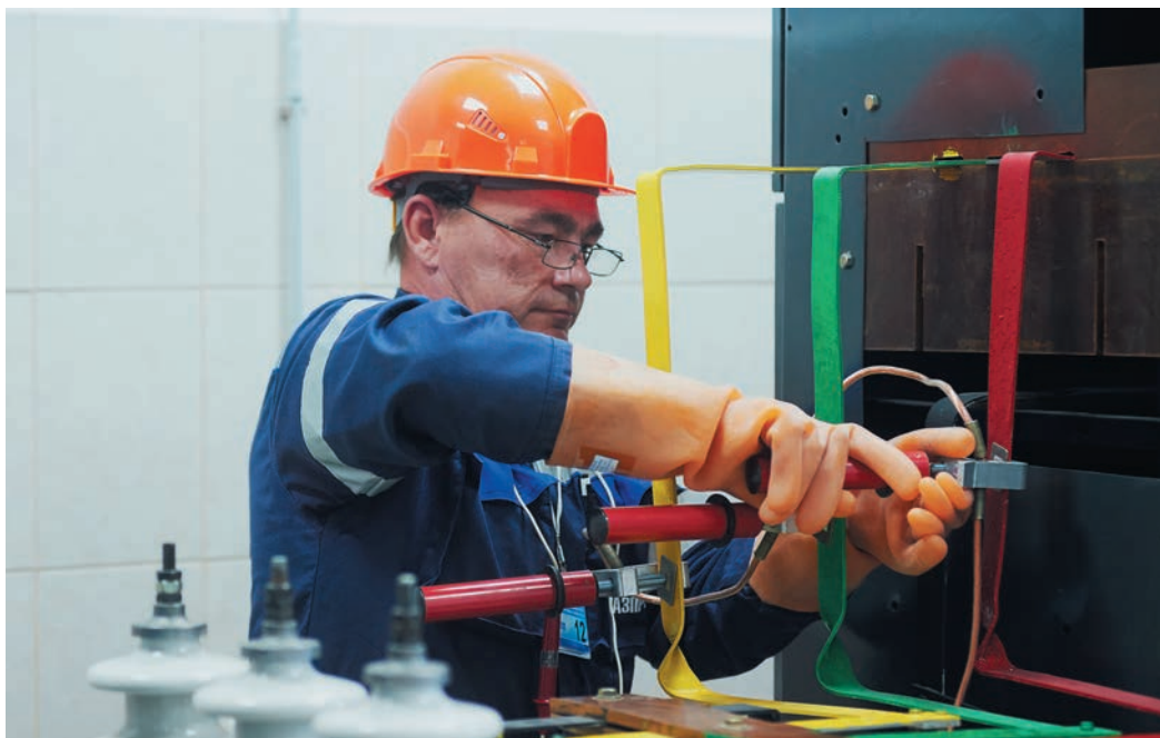
Одно из самых простых заданий — вывод в ремонт трансформатора
