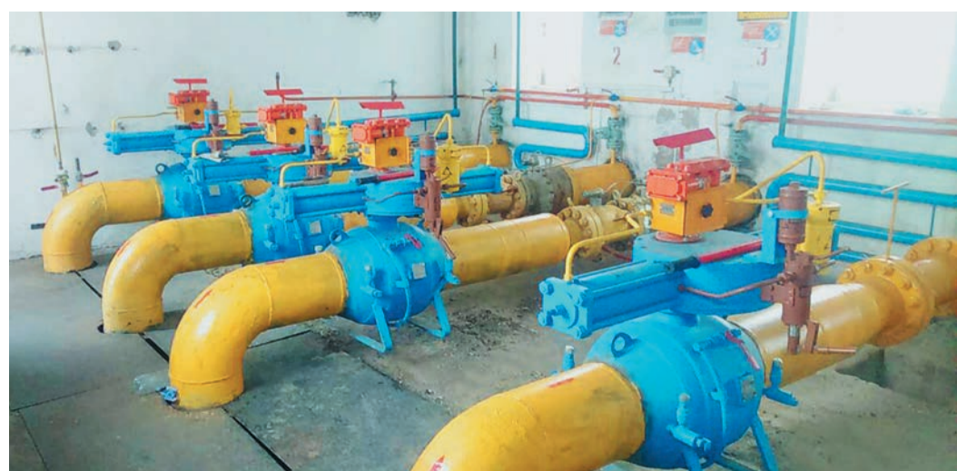
На ГРС-2 за последние годы полностью заменили крановую обвязку
