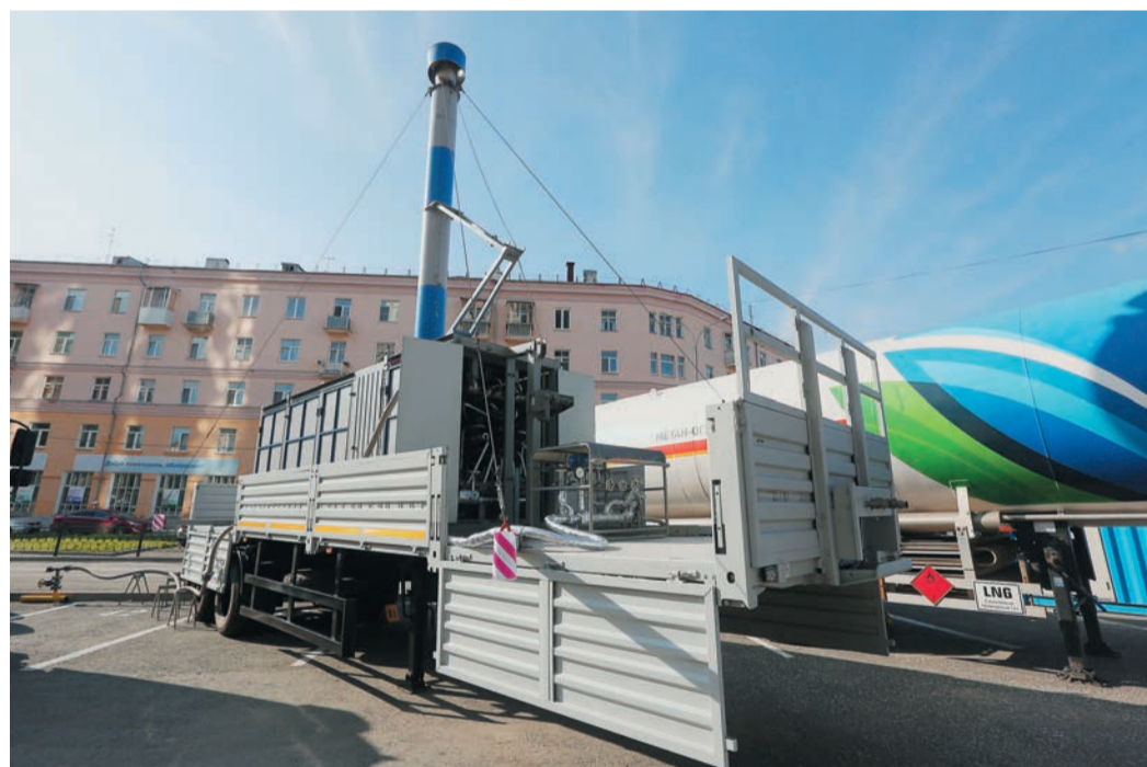
Технология применения СПГ для бесперебойного снабжения потребителей на время проведения капитального ремонта объектов магистрального транспорта газа была впервые использована в «Газпром трансгаз Екатеринбург». В 2017 году ее взяли на вооружение еще пять дочерних обществ ПАО «Газпром»
