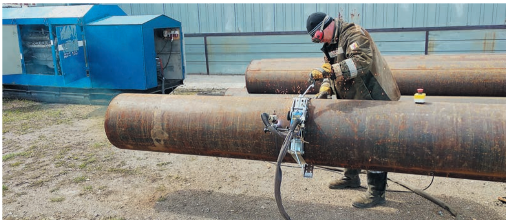
Плазморез может оказаться полезен при демонтаже протяженных участков газопровода
