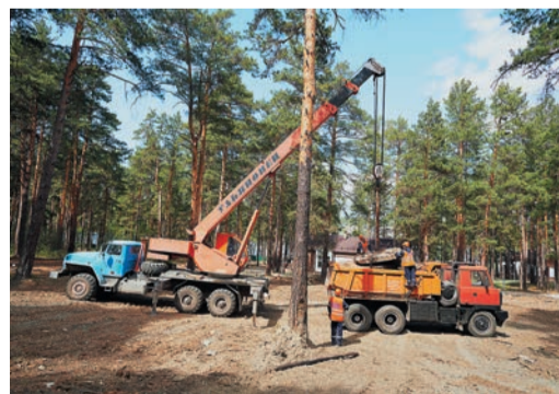
Продолжается вывоз оставшегося после капитального ремонта строительного мусора
