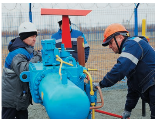
На полигоне линтрубы наносили изоляционное покрытие и переустанавливали шаровый кран
