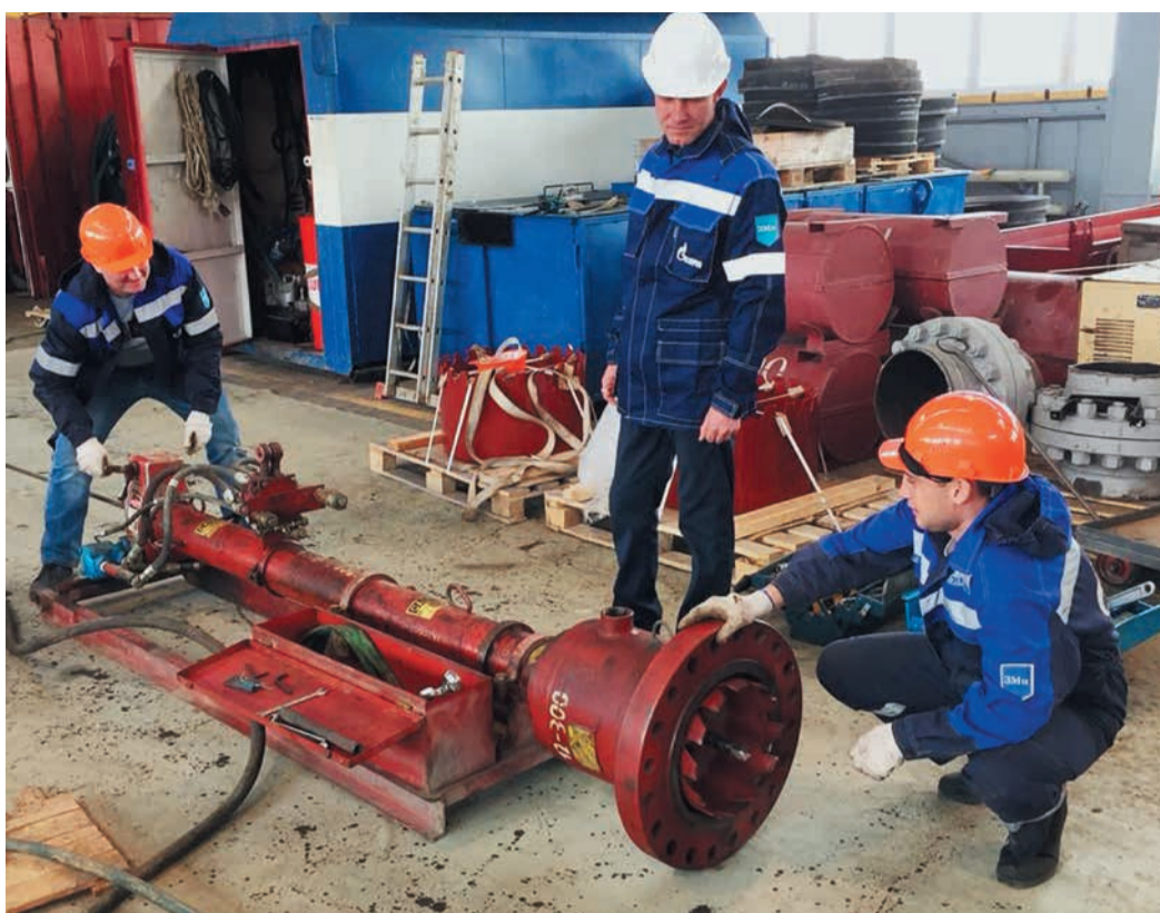
Максим Халаим (в белой каске) обучает правилам работы с оборудованием для врезки под давлением
