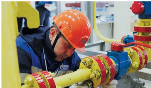
Практическая часть смотра затрагивает основные рабочие моменты: прием и передача смены, умение установить заглушку на газопроводе и провести ревизию клапана
