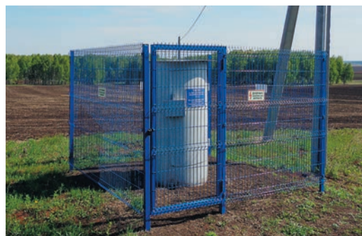
7-километровый анод подключили к станции катодной защиты на чебаркульском отводе
