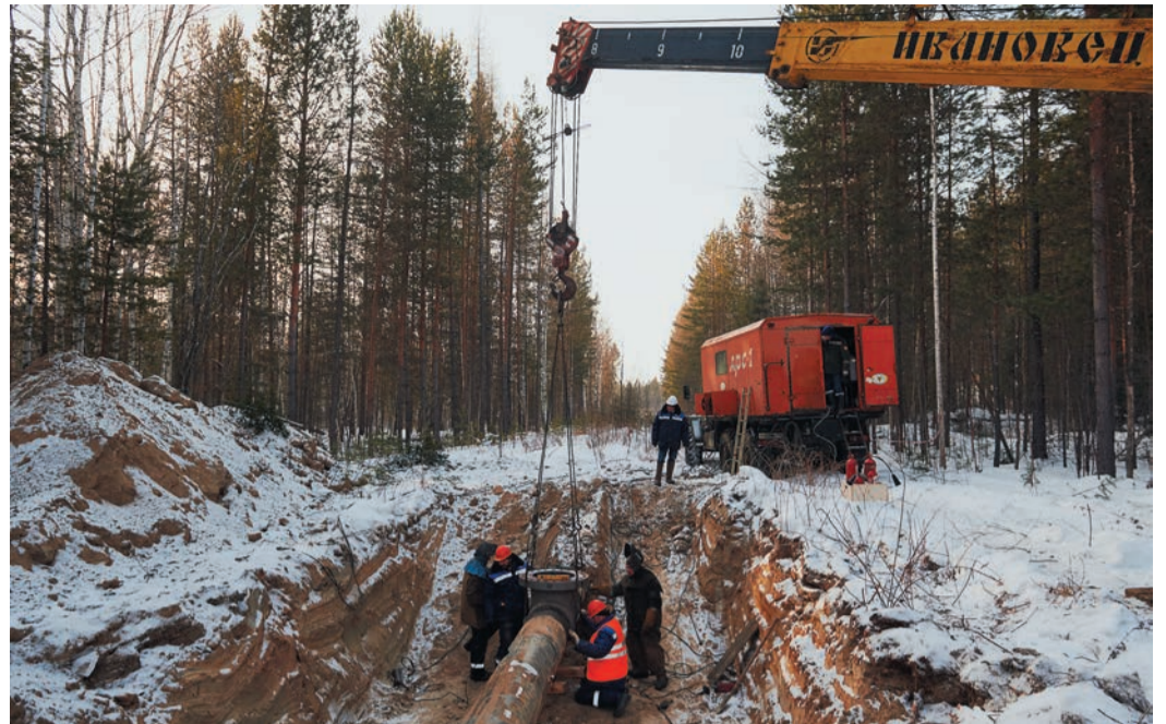
Первый шаг к врезке под давлением — сборка разрезного тройника
