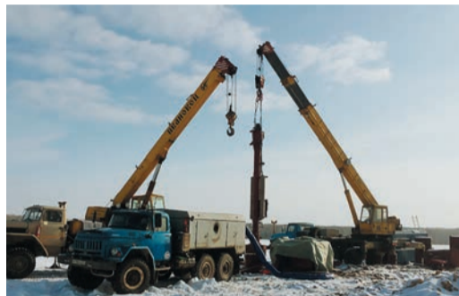
На «Бухаре — Урал» задействовали самую мощную установку, которую монтируют сразу два подъемных крана
