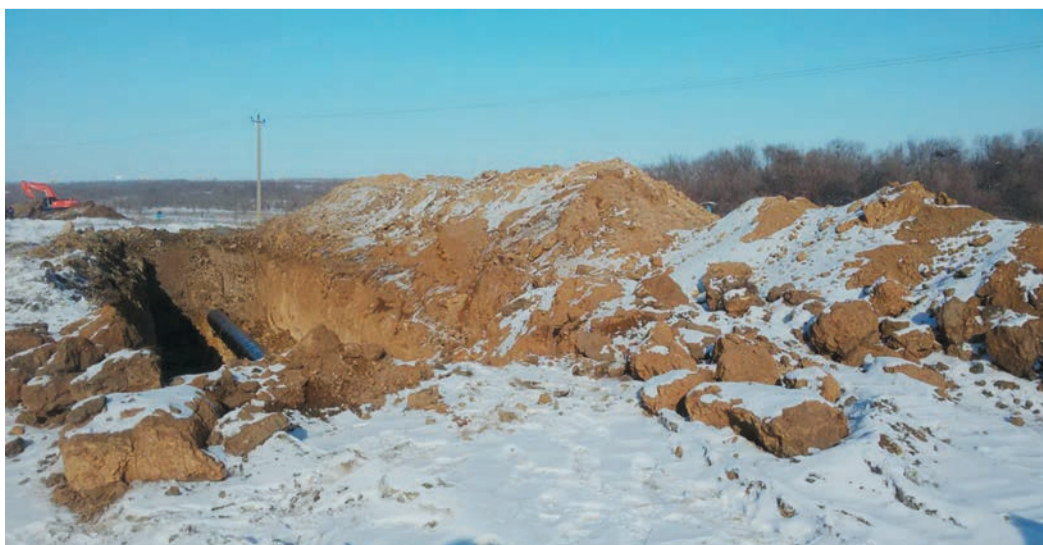
Цепочка шурфов растянулась почти на 46 километров
