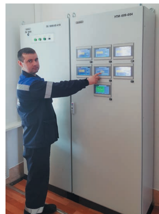
Приборист Александр Мирошников помогал в монтаже и настройке пожарной сигнализации
