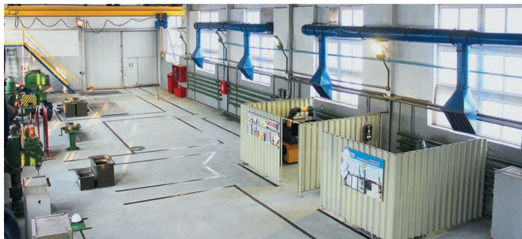
Отремонтированный цех приобрел законченный вид после нанесения разметки
