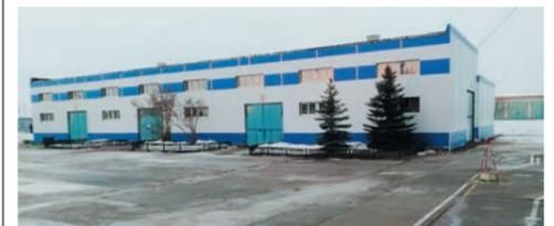
На площадке Карталинского ЛПУМГ капитально отремонтировали здание ремонтно-механических мастерских (РММ). Работы длились примерно два месяца. За это время заменили мягкую кровлю, установили новые противопожарные металлические двери, покрасили стены внутри. Самый трудоемкий этап работ — замена наружной обшивки здания. Старый профлист сняли и вместо него смонтировали более тысячи квадратных метров металло-сайдинга корпоративных цветов Газпрома.
