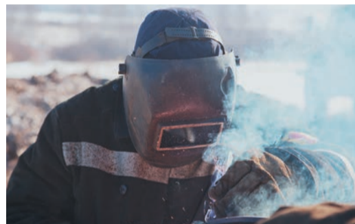
В ходе ремонта сварщики сделали около 2,5 тысяч стыков
