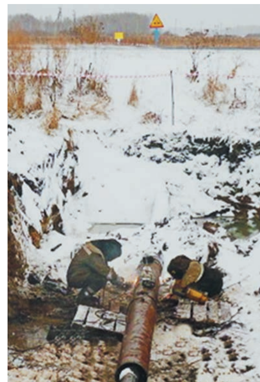
Трубу-патрон нарастили без остановки газопровода
