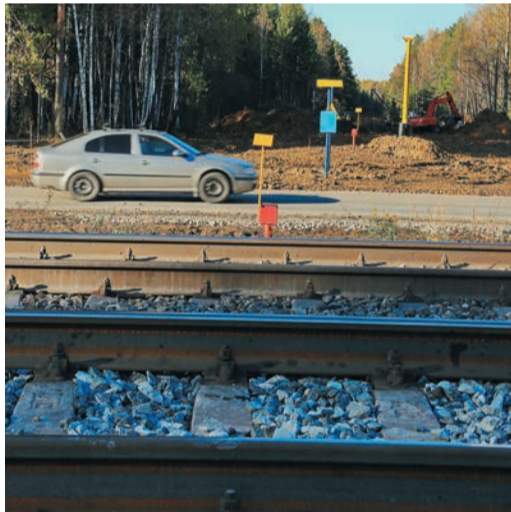
Газовую реку укрывает семиметровый слой земли и два слоя высокопрочной стали
