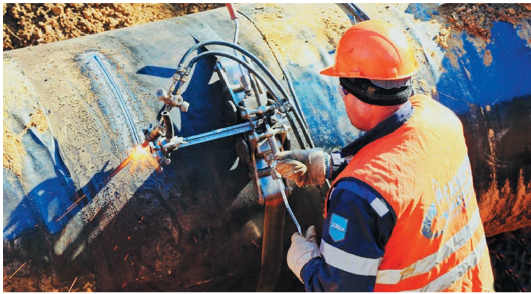
Огневые — завершающая стадия напряженных работ по строительству нового перехода
