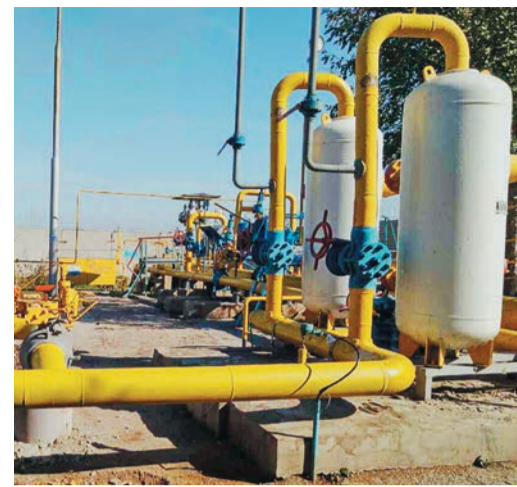
Все сварочно-монтажные работы на станции выполнены работниками Карталинского ЛПУМГ
