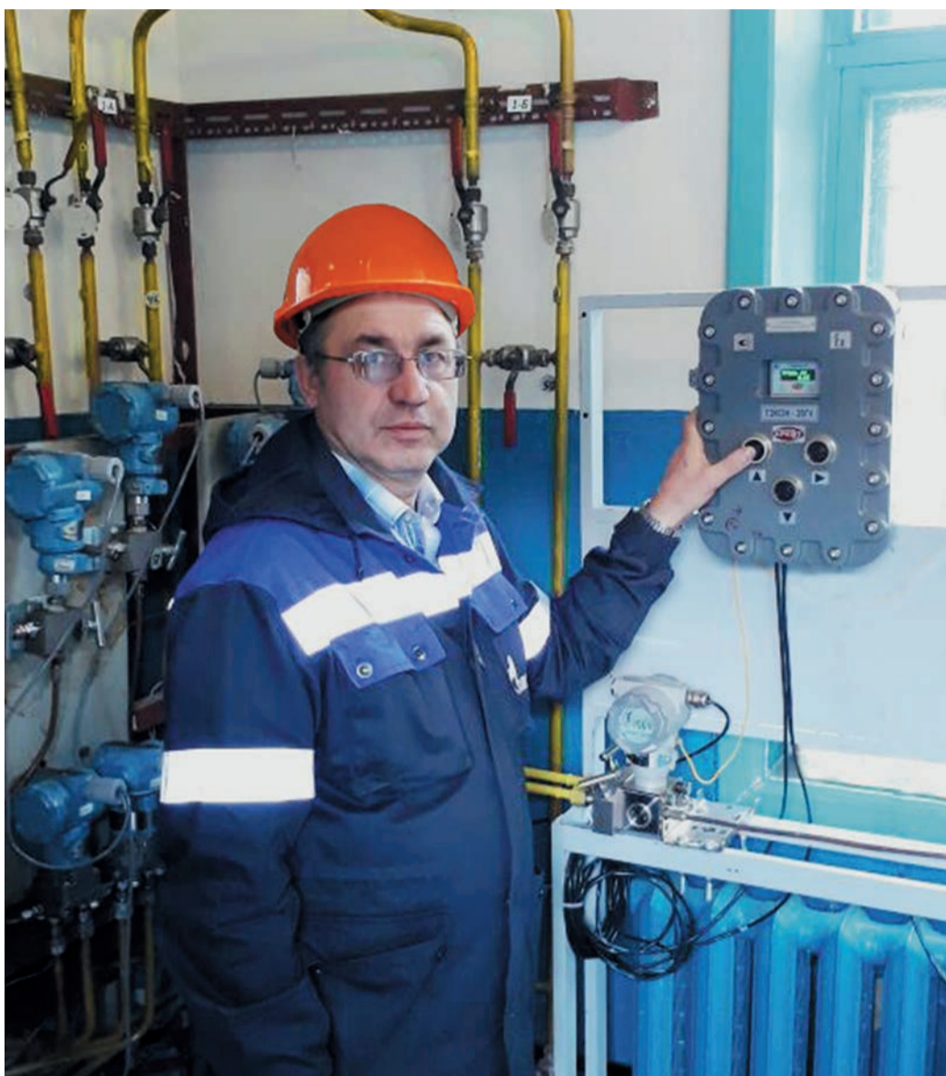
Владимир Окулов и его коллеги подключили взрывозащищенный контроллер без проведения огневых работ
