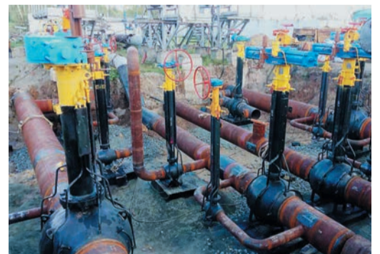
Капитальный ремонт выполнили хозяйством
