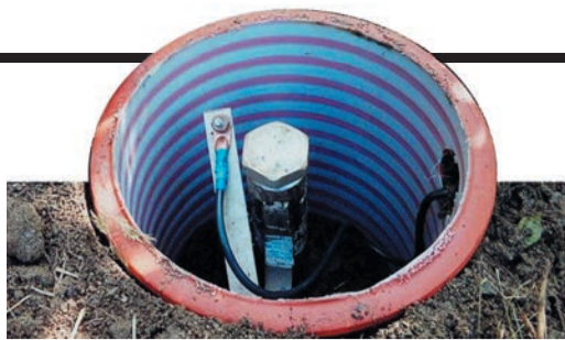
От электрического удара станцию защитит трубка с солью
