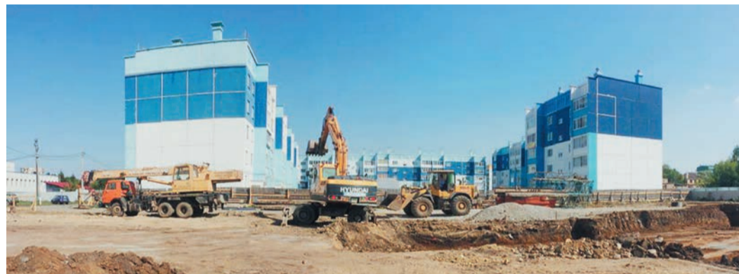
Уже к зиме на месте котлована вырастет коробка пятиэтажного дома
