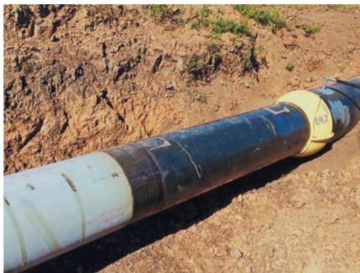
Трубы в эпоксидной и полиэтиленовой изоляции уложены в одну нитку
