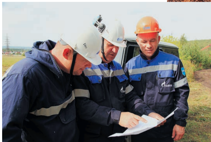
Работы на ГРС-3 и газопроводе-отводе контролировали начальники служб и участков
