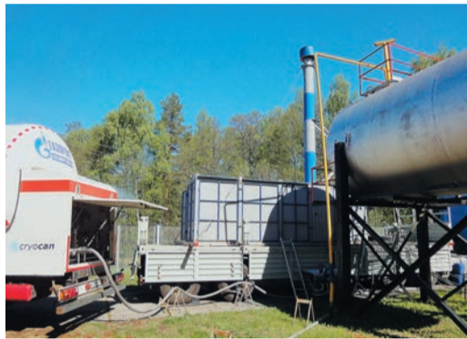
Работы на ГРС поселка Новозавидовское (Крюковское ЛПУМГ «Газпром трансгаз Москва»)
