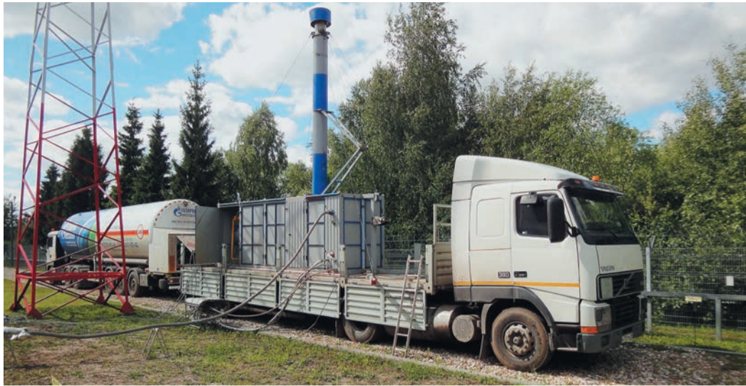
СПГ и оборудование прибыли на ГРС «Редкино» (Торжокское ЛПУМГ «Газпром трансгаз Санкт-Петербург»)
