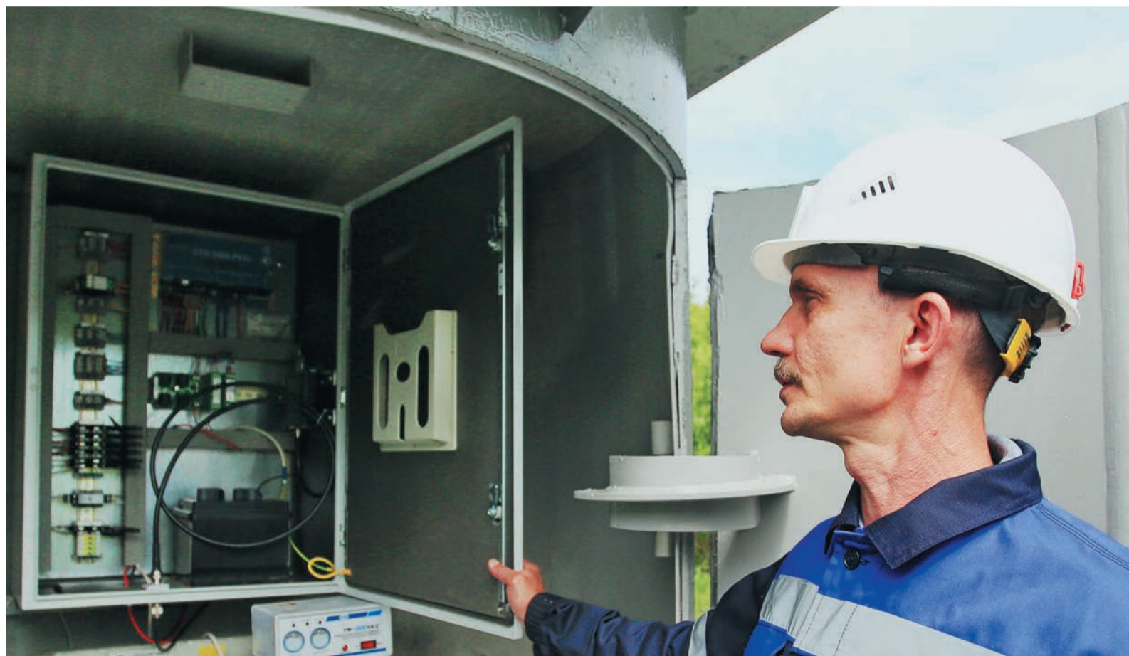
Алексей Шевченко уверен, что контроль за работой системы электрохимзащиты станет теперь более оперативным
