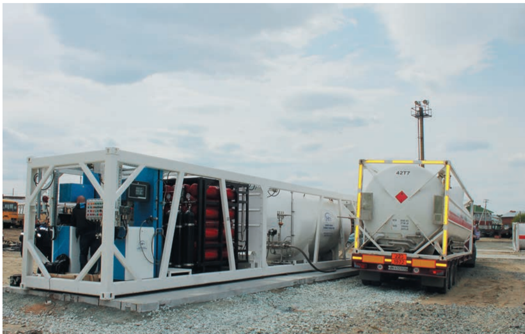
На строительство обычной АГНКС уходит 3–4 месяца, а для установки «контейнерной» КриоАЗС достаточно нескольких дней
