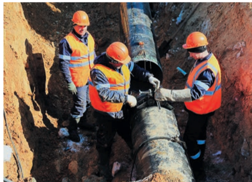
После того как УАВРовцы соединили трубы катушкой, на новую ГРС пошел газ
