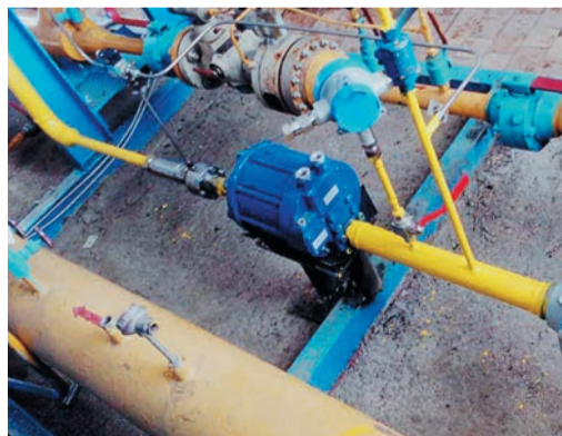
Турбодетандер установили параллельно редуцирующему клапану
