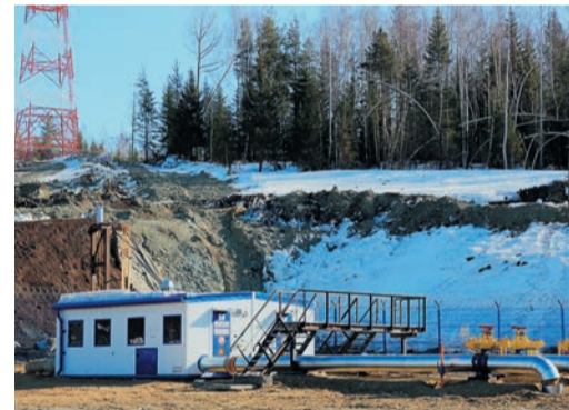
После того как УАВРовцы соединили трубы катушкой, на новую ГРС пошел газ
