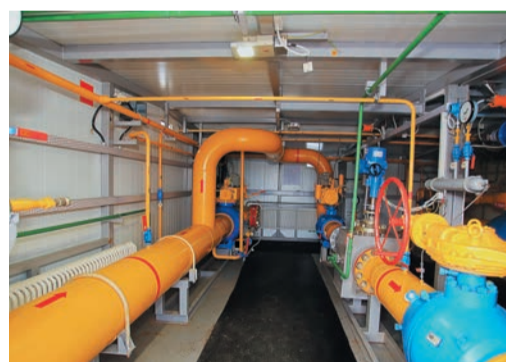
Различные датчики показывают давление газа, температуру и иные параметры. Кроме круглых циферблатов со стрелками встречаются и жидкокристаллические табло
