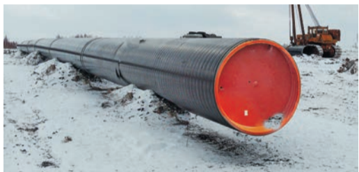
За неделю газовики заменили более 80 м трубы Ду 1400
