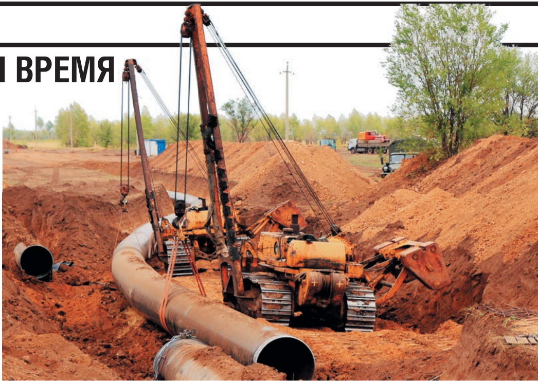
В УАВР-2 умеют работать с газопроводами любого диаметра и любой сложности
