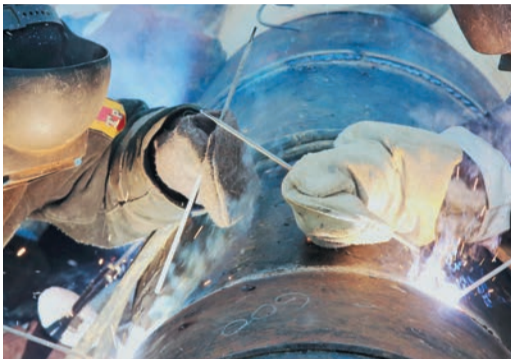
Первоуральскую трассу укрепляют стальными муфтами
