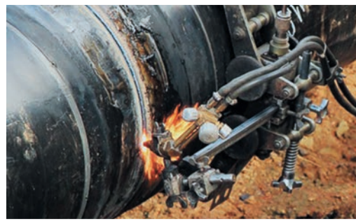
Капремонт начался с демонтажа старой трубы
