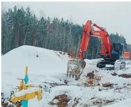
Ликвидация дефектов начинается и заканчивается земляными работами
