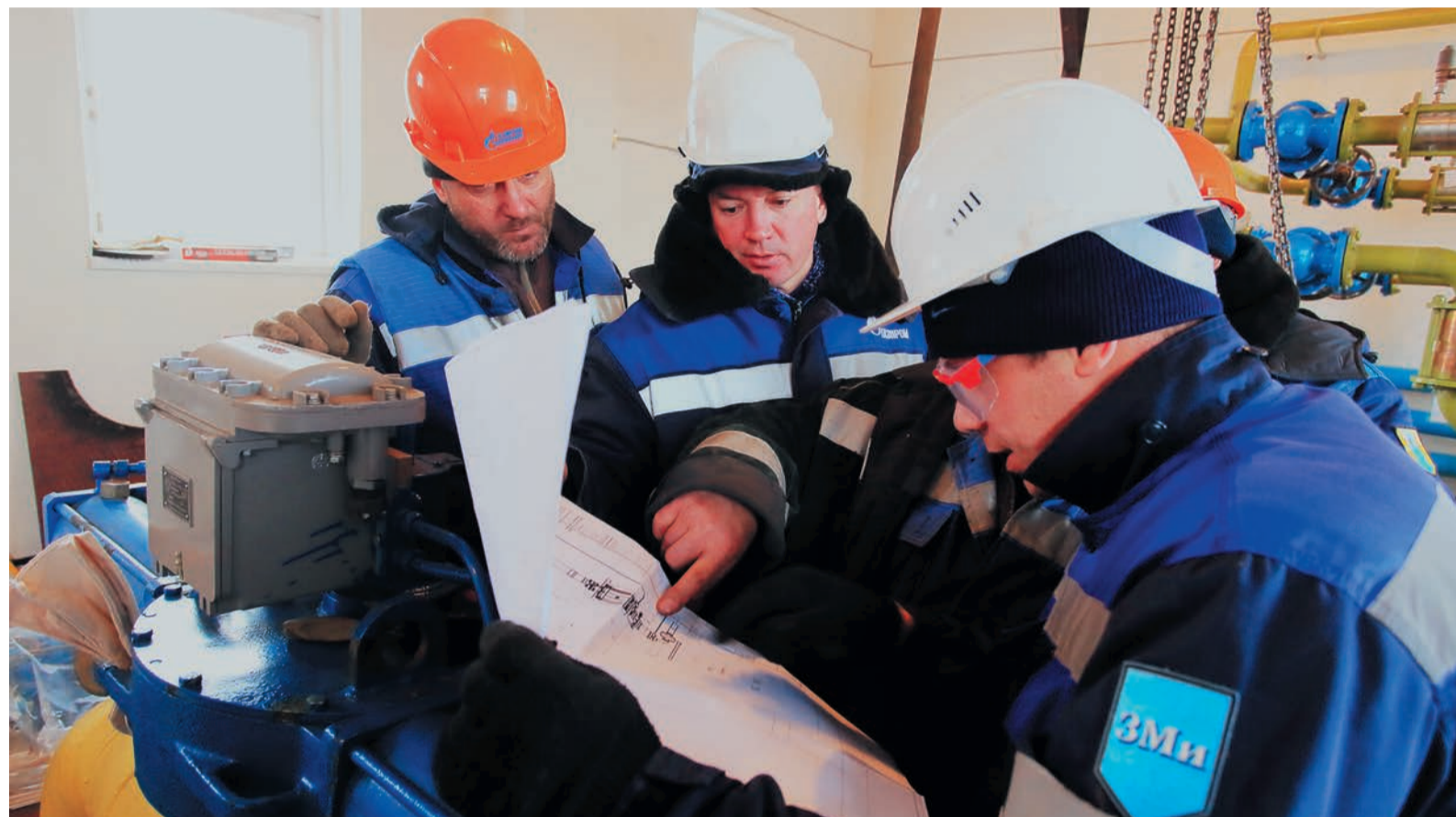
Установка турбодетандера на ГРС-4 ведется строго по плану
