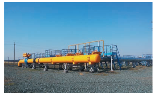
ГИС «Саракташ» после реконструкции
