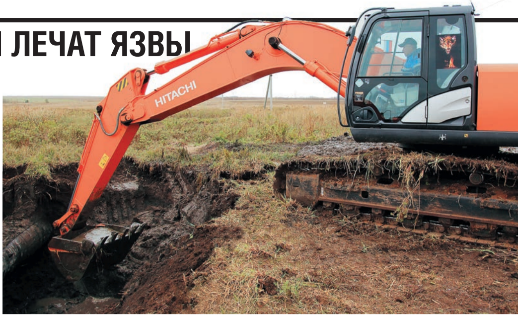
Пока идет ремонт, Борис Облицов следит за уровнем воды в траншее
