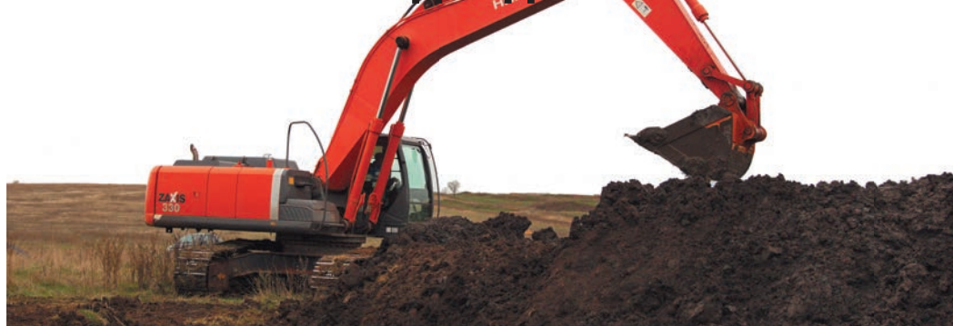
Сначала снимают плодородный слой грунта
