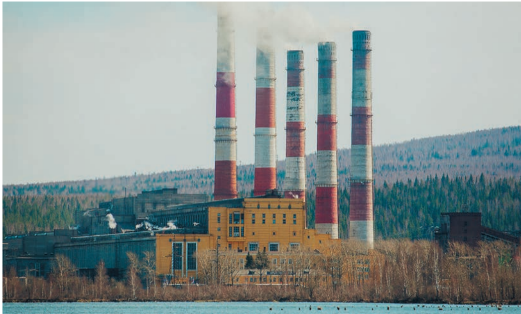
Парогазовая установка позволит вывести из работы три угольных энергоблока с 60-летней историей
