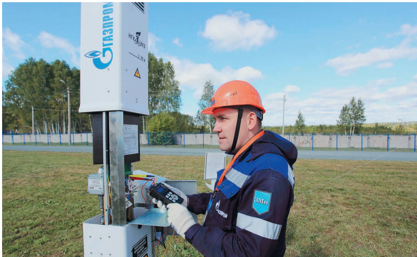
На учебном полигоне ООО «Газпром трансгаз Екатеринбург» были воссозданы основные ситуации из жизни монтеров-коррозионщиков
