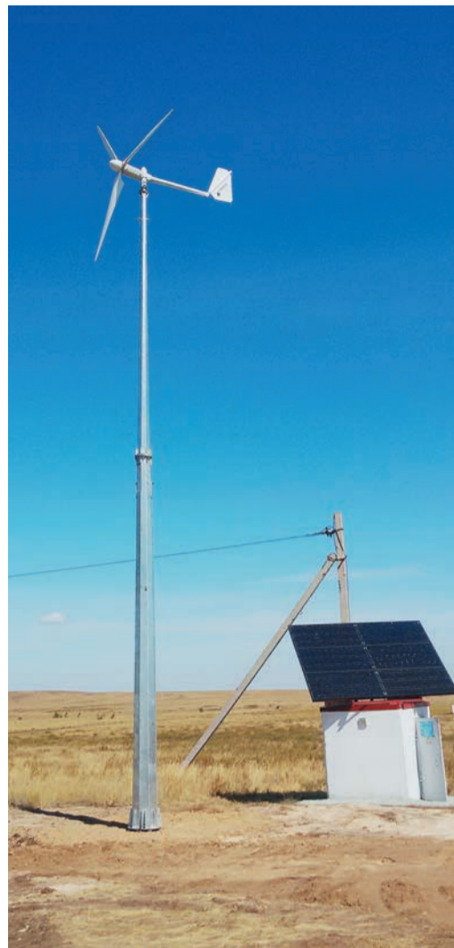
Лопасти ротора совершают до 380 оборотов в минуту, создавая ветряное колесо диаметром в 3,8 метра
