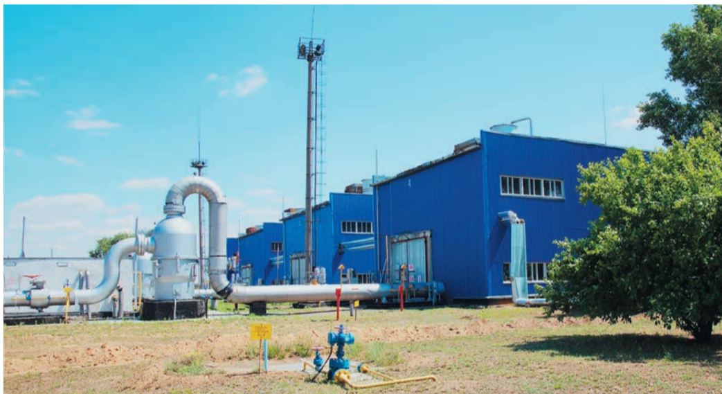
Самым напряженным моментом комплекса стали работы на обвязке КЦ «Новопсков»
