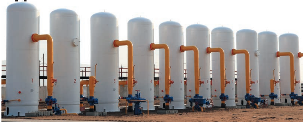
Чтобы заменить выходные шлейфы пылеуловителей, монтажники и сварщики поднимались на 5-метровую высоту
