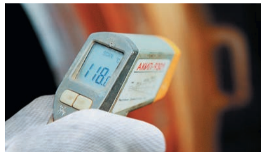
Температура внутри трубы превышает 100 градусов
