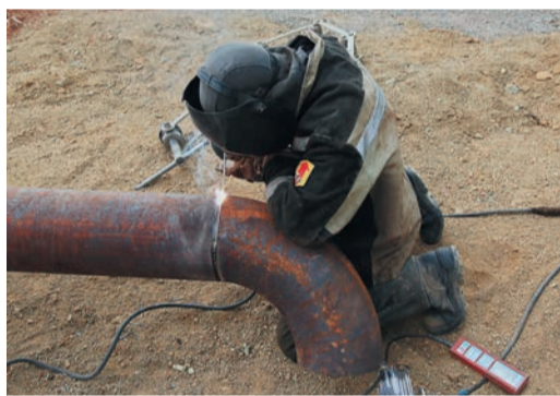
На КС-17 сварщики не допустили ни одного дефектного стыка
