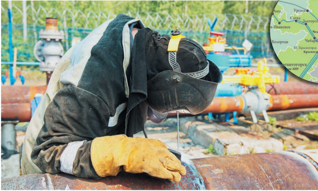
Чтобы приступить к монтажу ниток редуцирования, бригаде УАВР-1 осталось закончить сварку и установку выходного коллектора
