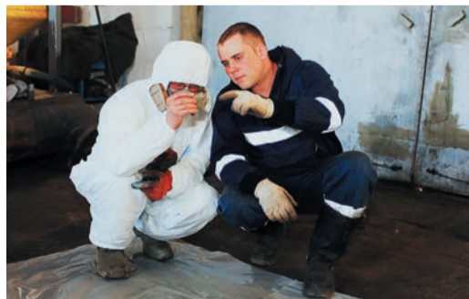
Изоляровщик Олег Макаров и монтажник Станислав Новицкий проверяют качество изоляционного слоя
