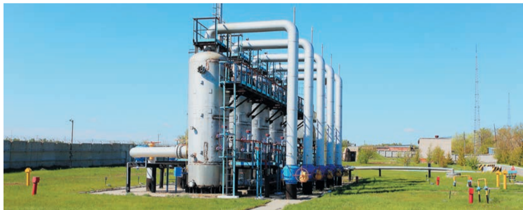
В ходе экспертизы были прослушаны, просвечены и прокачаны даже пятиметровые колонны пылеуловителей
