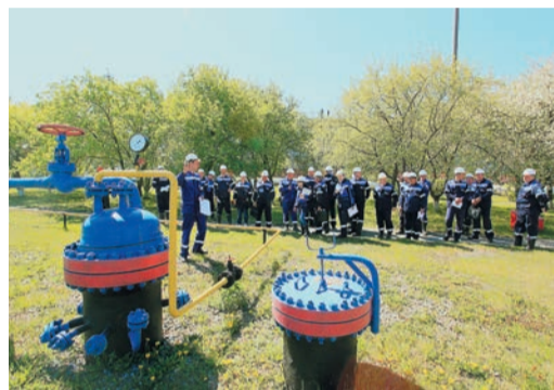
Инженеры прошли по ключевым объектам КС «Долгодеревенская»
