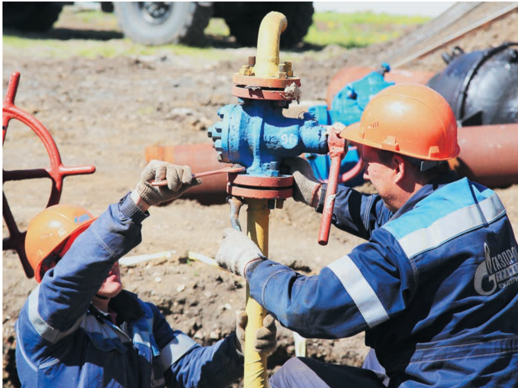
Старый свечной кран разбалчивают слесари ГРС Сергей Кузьмук (слева) и Дмитрий Важенин, новый приварят сварщики УАВР-3
