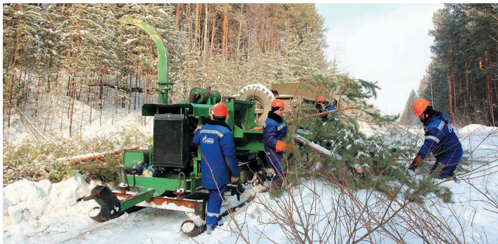
В УАВР-1 от работы бегать не принято: если не нужно спускаться в траншею, сварочно-монтажная бригада готова отправиться на расчистку вдольтрассовых просек
