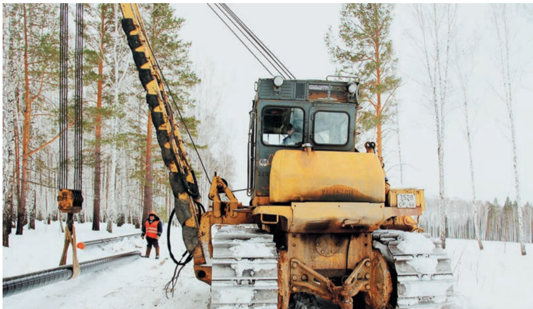
За день на двуреченском отводе бригада УАВР-3 успевает сварить 12–15 труб
