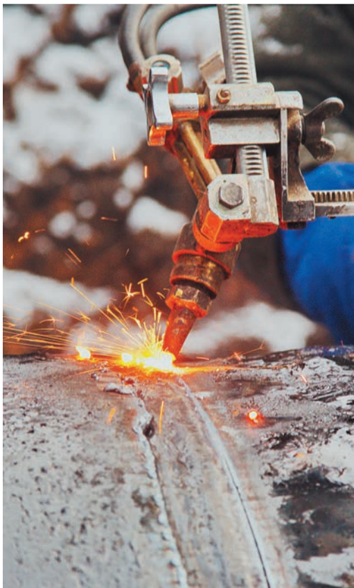
В ходе ремонта было заменено 400 м поврежденной трубы
