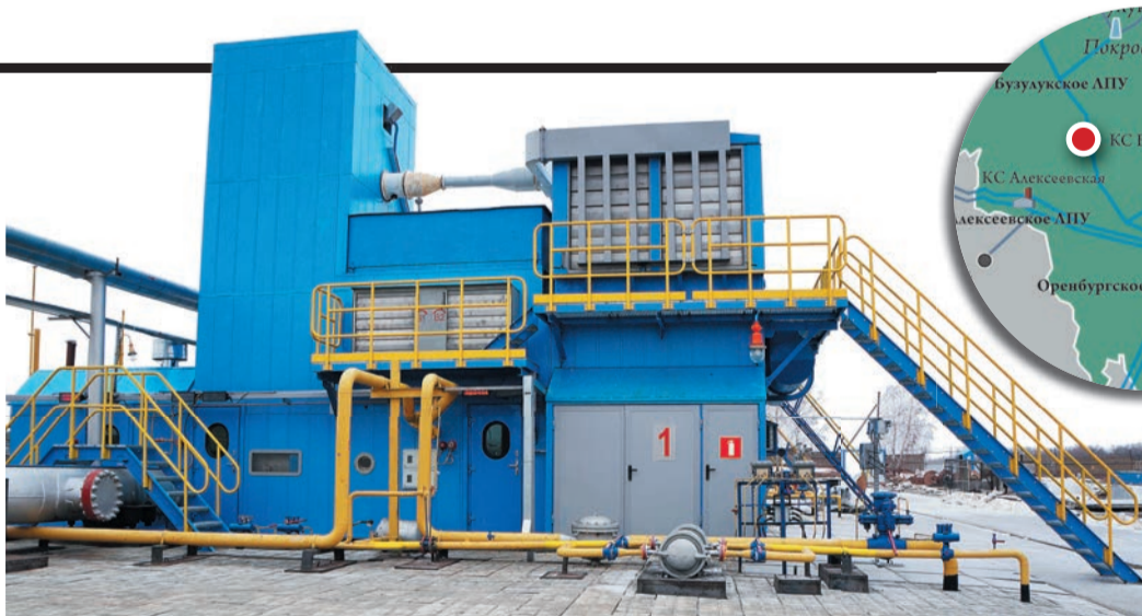
Новое укрытие радует глаз, лучше держит тепло и обеспечивает безопасный подход к ГПА
