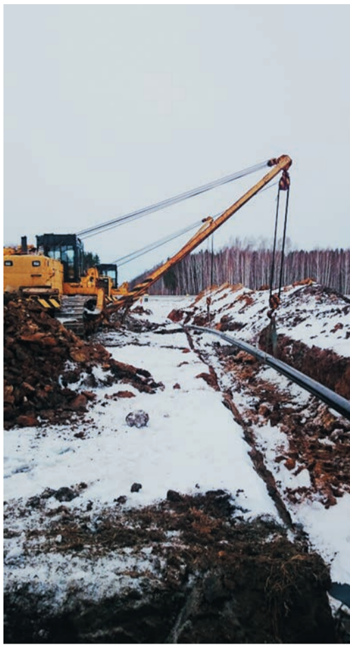
В ходе комплекса выполнено четыре врезки
