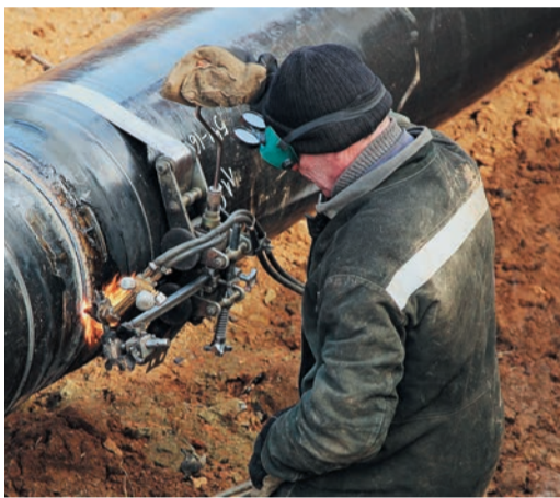
Весь год продолжался ремонт главного газопровода-отвода Красногорского ЛПУ
