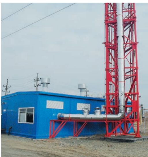
В котельной поселка Голубой Факел Домбаровского ЛПУ установлено четыре новых котла общей мощностью 8 МВт
