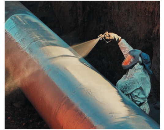
Изоляторы УАВР-2 на шлейфах КЦ «Союз»
