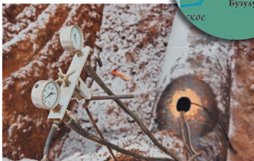
Завершение комплекса ремонтных работ совпало с первым снегом в Оренбуржье
