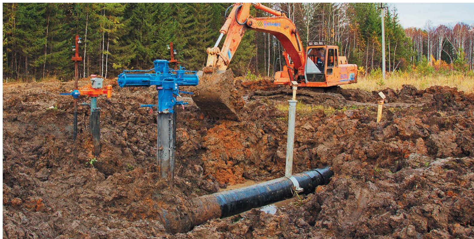
В Невьянском ЛПУ завершены работы на самой северной из четырех технологических перемычек, на которых запланирован ремонт
