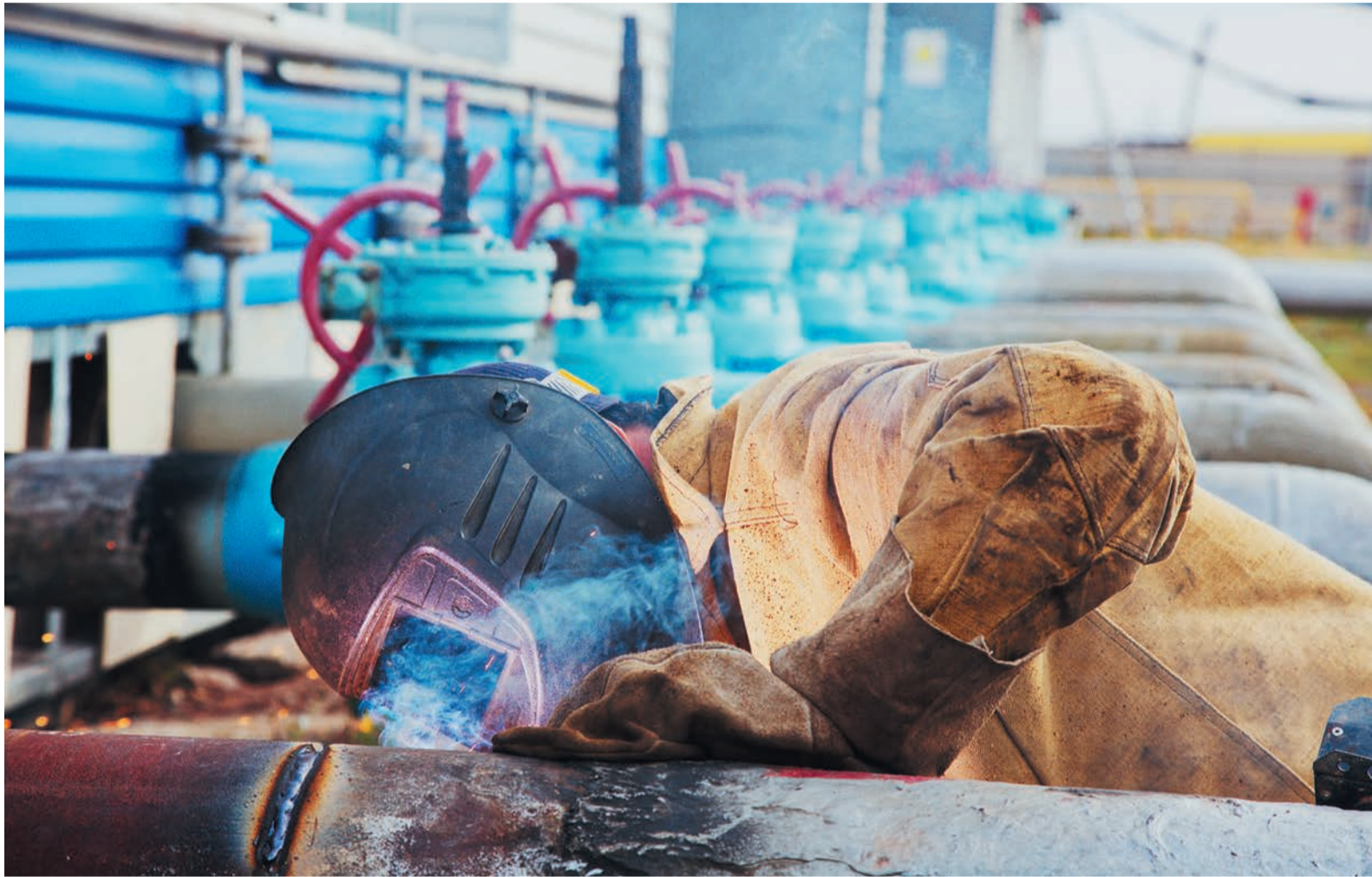
Лицевой шов почти завершен, впереди у сварщика Марса Мустакова еще шесть кранов
